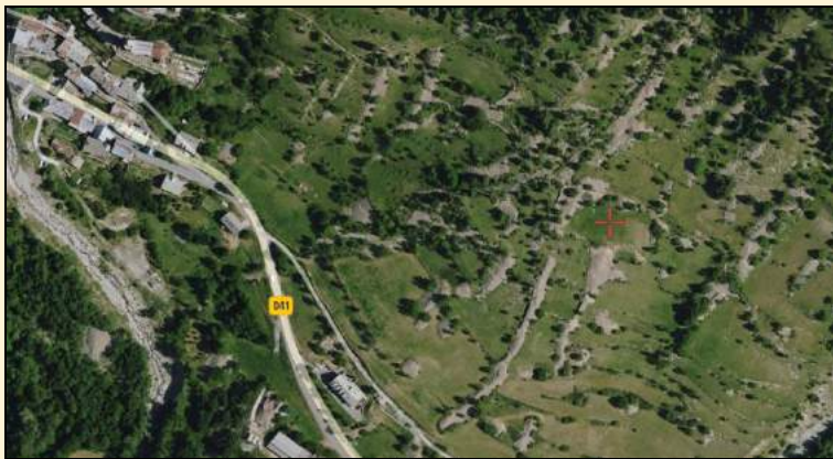
Vue aérienne des murets, terrasses et clapiers
