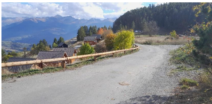
Barrière de sécurité au-dessus des Chalets des Aiguilles.
