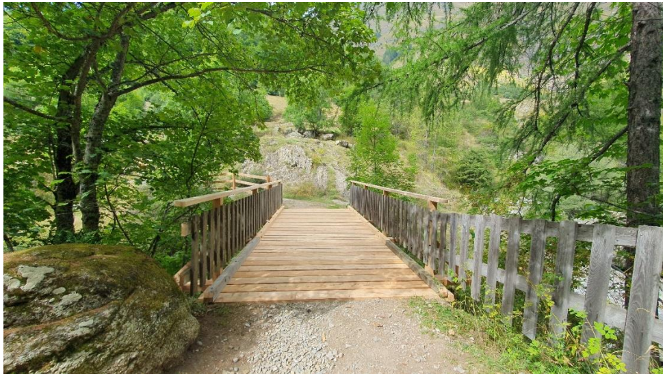
Pont de la Marmite aux Gourniers réalisé par « Guillaume Multi Services ». Merci à lui.
